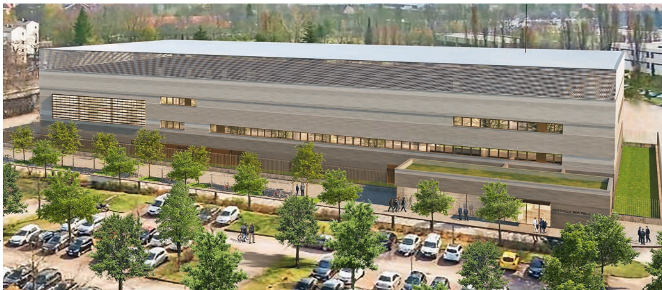
Die neue Polizeieinsatzzentrale und das Lagezentrum der Berliner Polizei.
