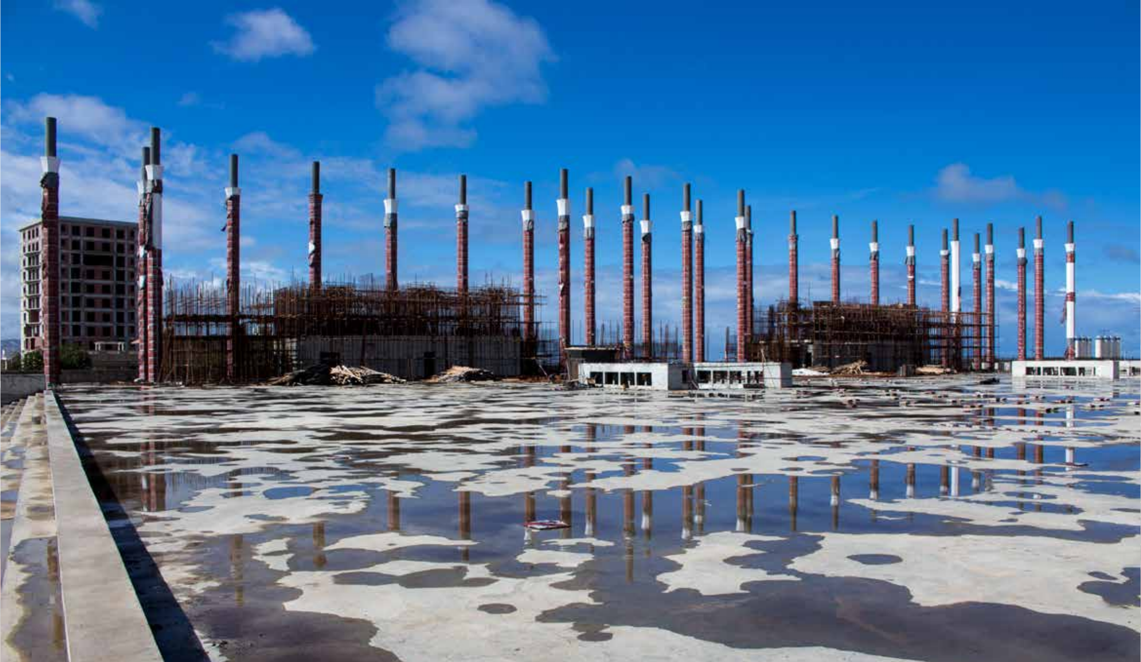
Bauteil C westliches Ende
