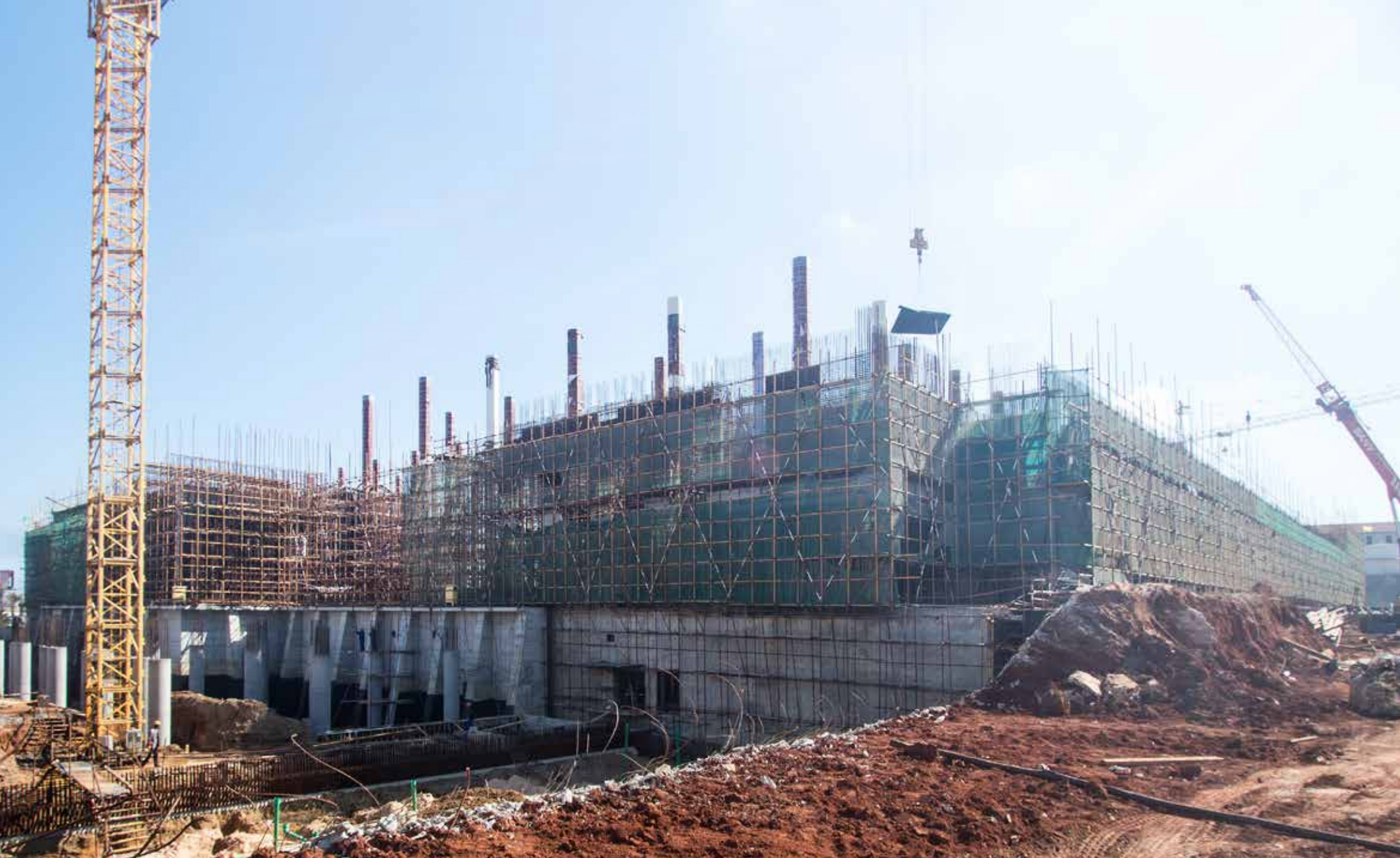
Bauteil A von Südwesten
