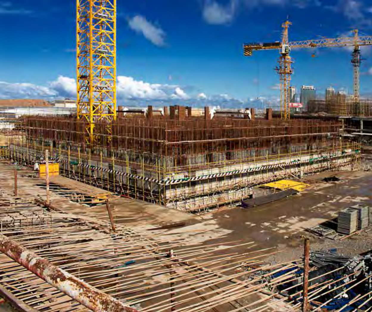
Bauteil B Februar 2015
